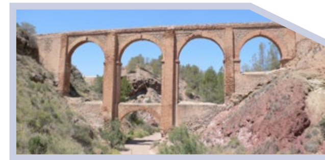
Fig. 2. Aqüeducte de los Cinco Ojos al Paratge Natural Municipal de los Algezares (Asp).
