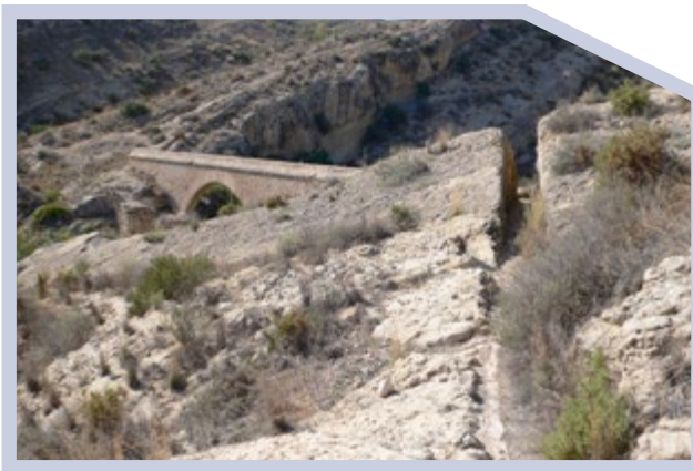
Fig. 5. Excavació de trinxeres per a permetre el pas de la canalització. Al fons, aqüeducte d'un ull situat al paratge de la Casa de las Tablas. Pertany a la reforma realitzada sobre la conducció el 1862.
