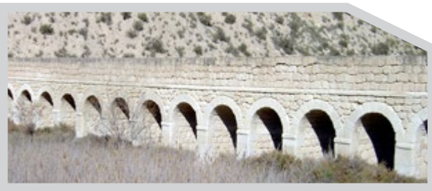
Canal de desviació construït per l'enginyer Próspero Lafarga.
