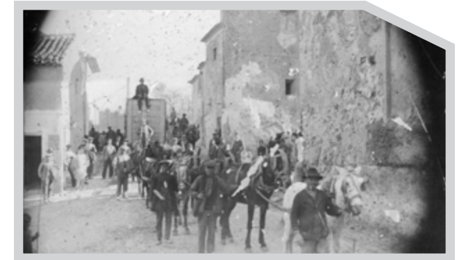
Transport del primer motor, Nuevos Riegos El Progreso.
