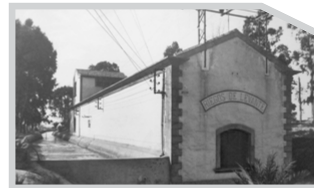
Canal principal i 1º Elevació, Riegos de Levante.
