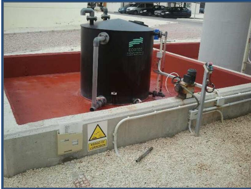
*Detalle del punto de carga del almacenamiento de Ácido Sulfúrico. ⑧*
