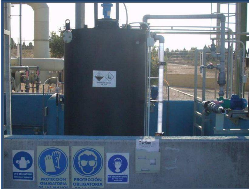
Detalle del punto de carga del almacenamiento de Hidróxido Sódico. (15)
