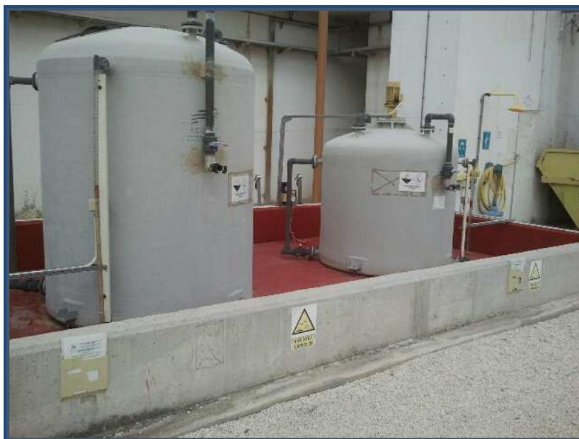
*Detalle de los puntos de carga de los almacenamientos de Hipoclorito e Hidróxido Sódico. ⑨ y ⑦*
