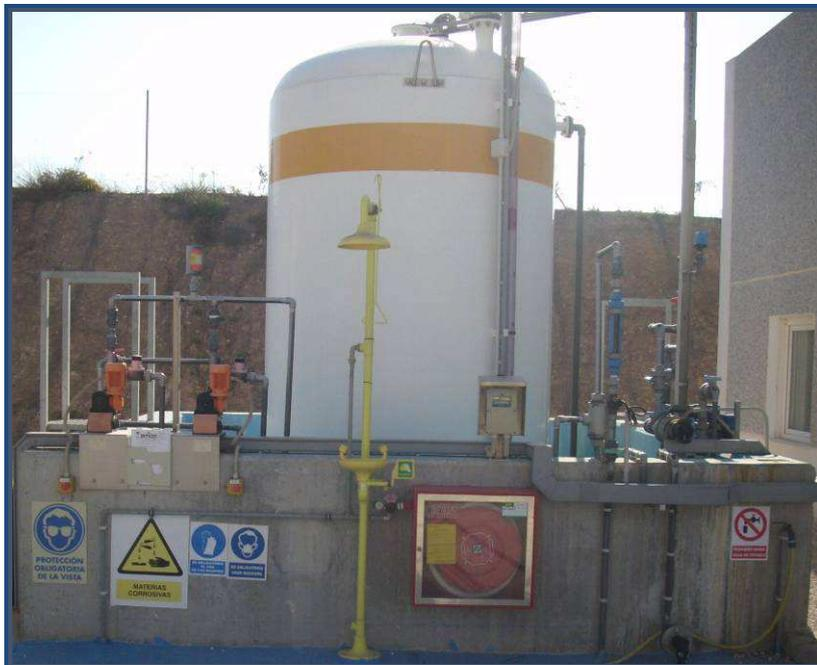
*Detalle del punto de carga del almacenamiento de Sulfato de Alúmina. (11)*
