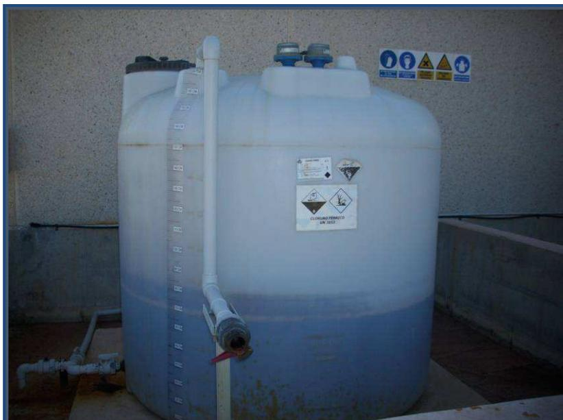
*Detalle del punto de carga del almacenamiento de Cloruro Férrico.㉑*
