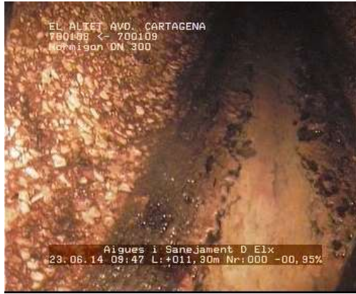
Estado de la red de alcantarillado
