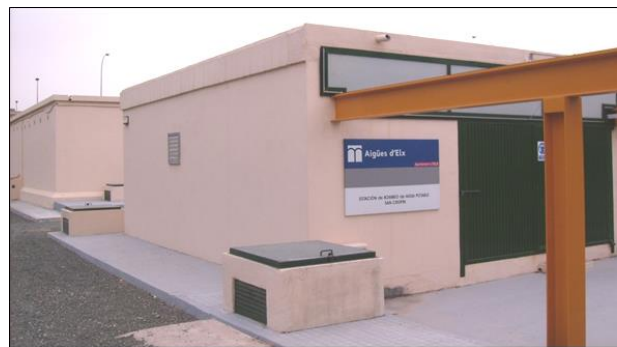
Depósito San Crispín
