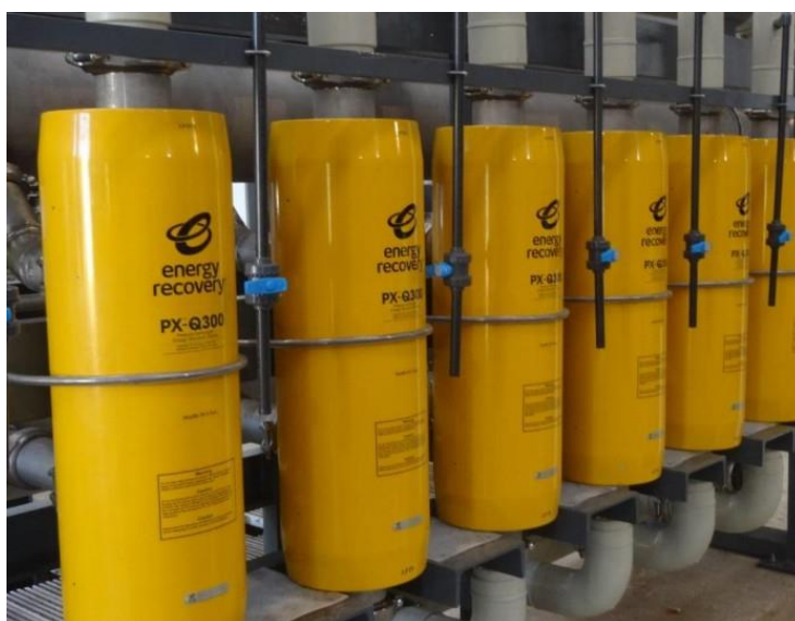
Figura 6.8. intercambiadores de presión ERI (Fuente: ERI).
