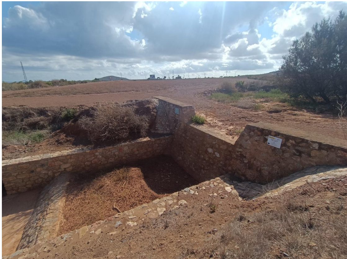
Figura 30 – Dique 9. Vista desde aguas abajo.
