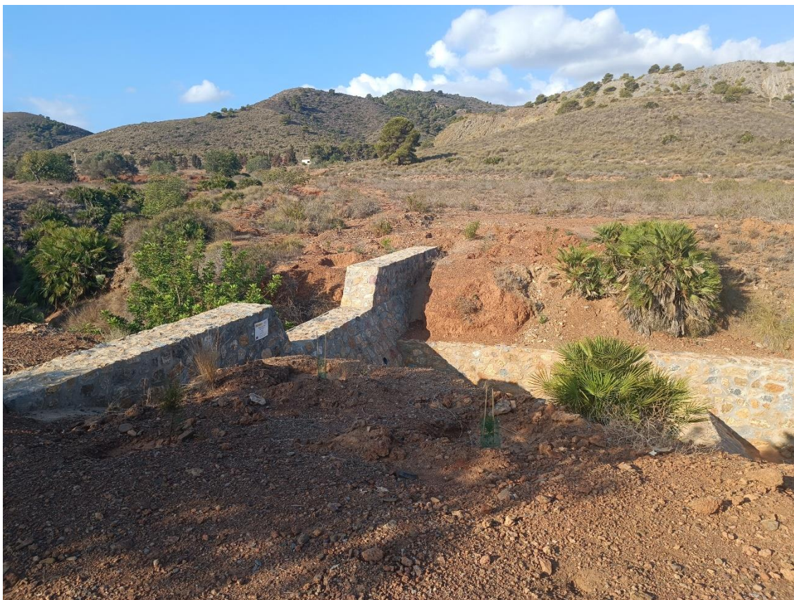
Figura 11 – Dique 2. Vista general.
