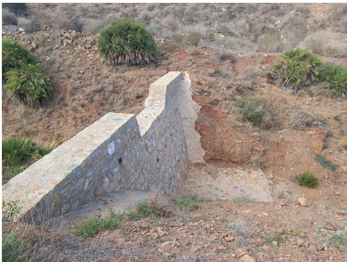
Figura 20 – Dique 5. Vista general.
