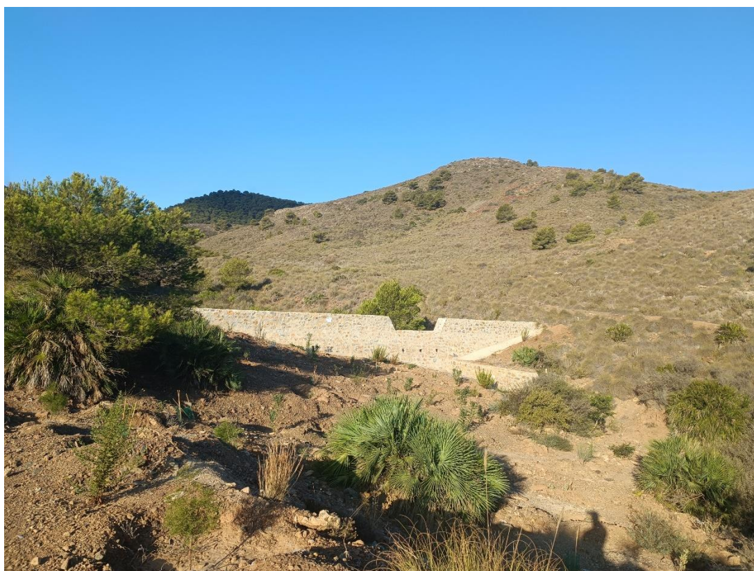
Figura 2 – Dique 1. Vista general.
