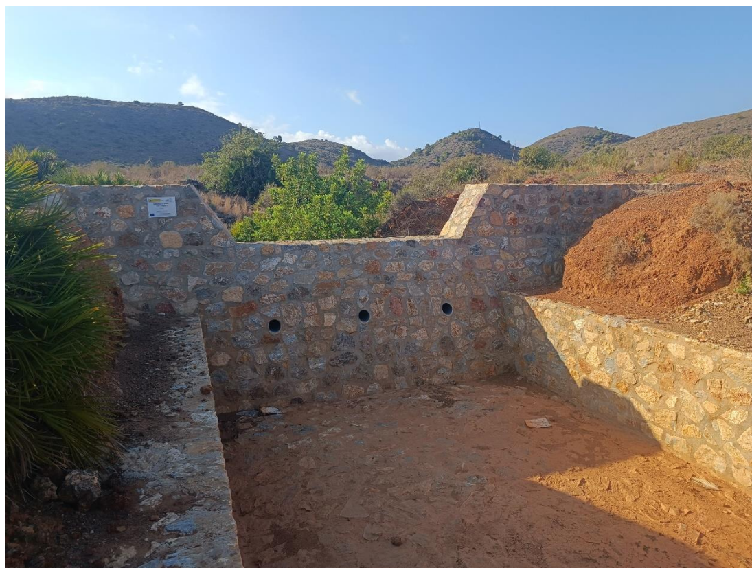
Figura 12 – Dique 2. Vista desde aguas abajo.
