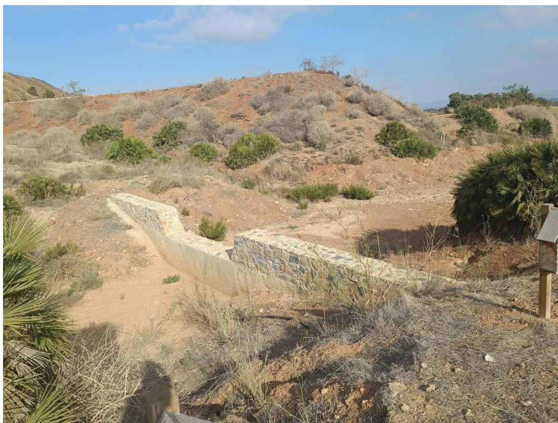
Figura 22 – Dique 6. Vista general.
