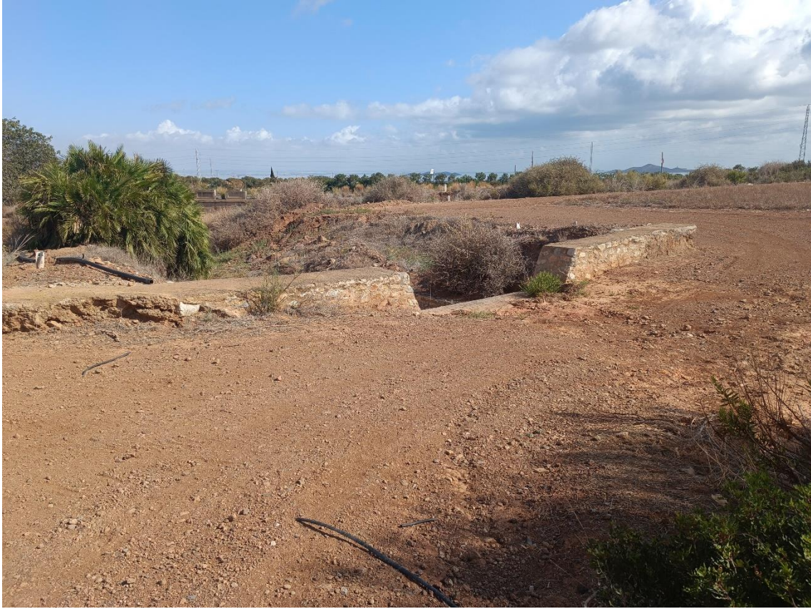
Figura 29 – Dique 9. Vista desde aguas arriba.
