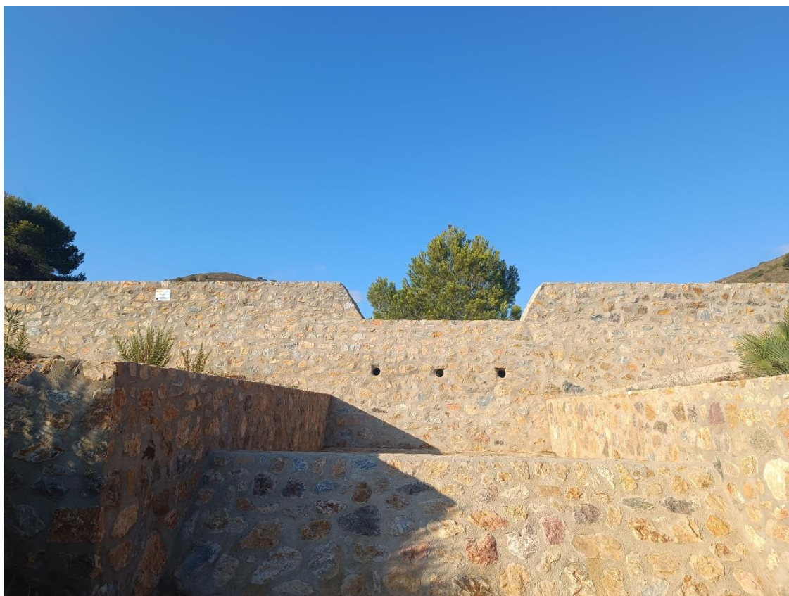
Figura 4 – Dique 1. Vista desde aguas abajo.
