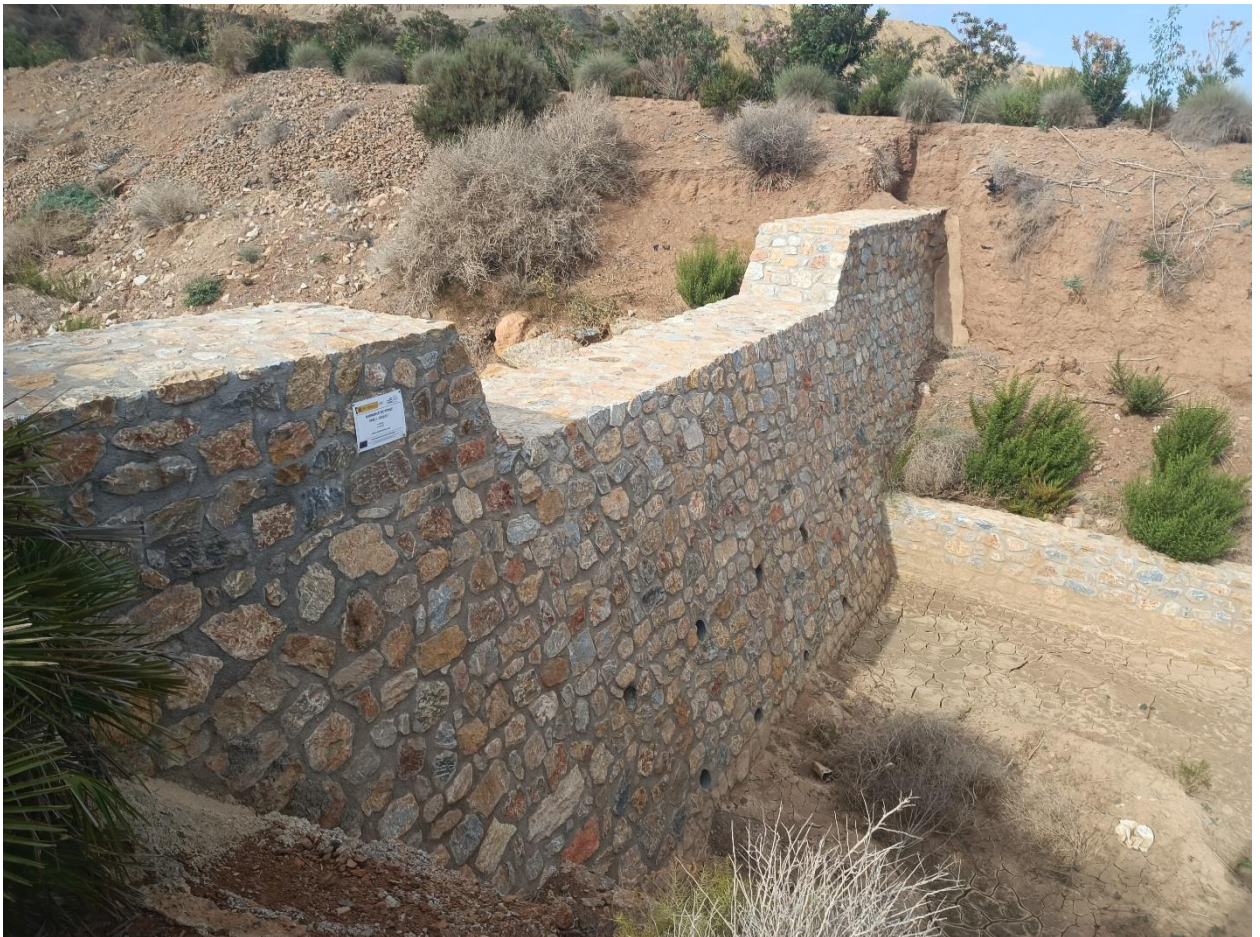
Figura 24 – Dique 7. Vista general.
