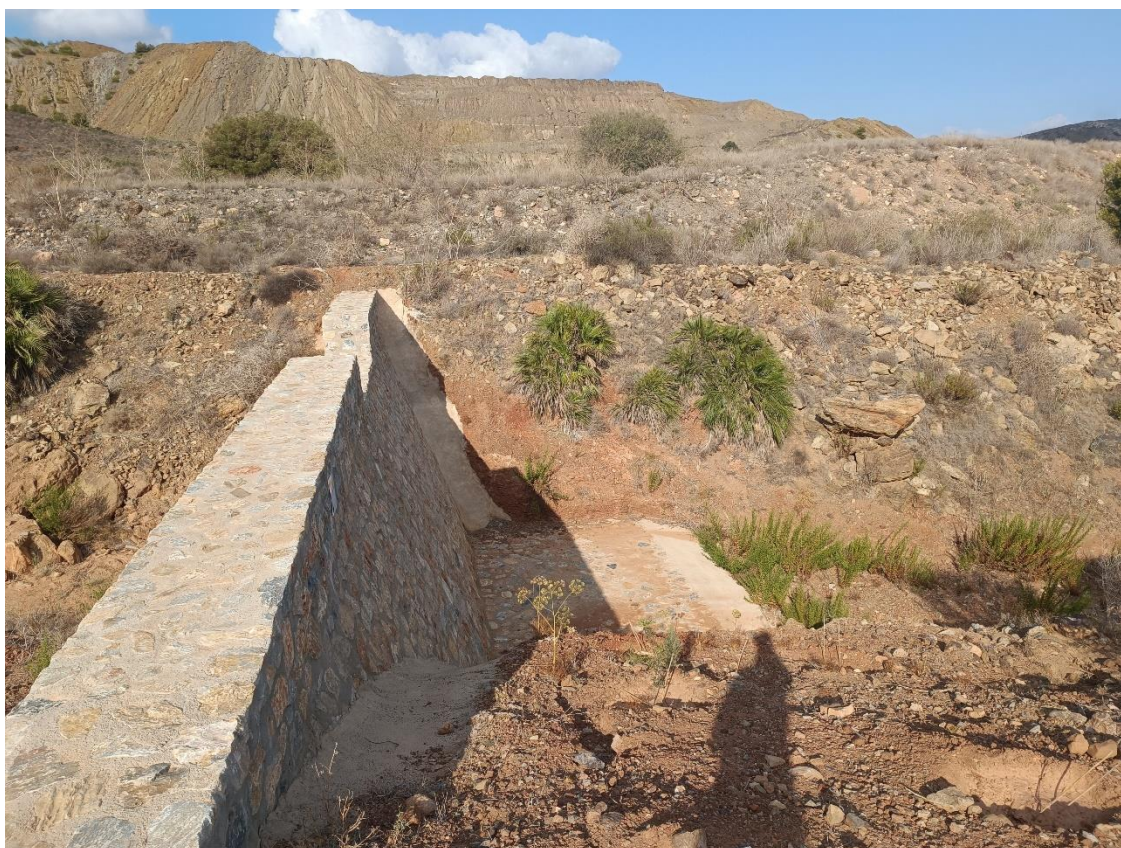
Figura 18 – Dique 4. Vista general.
