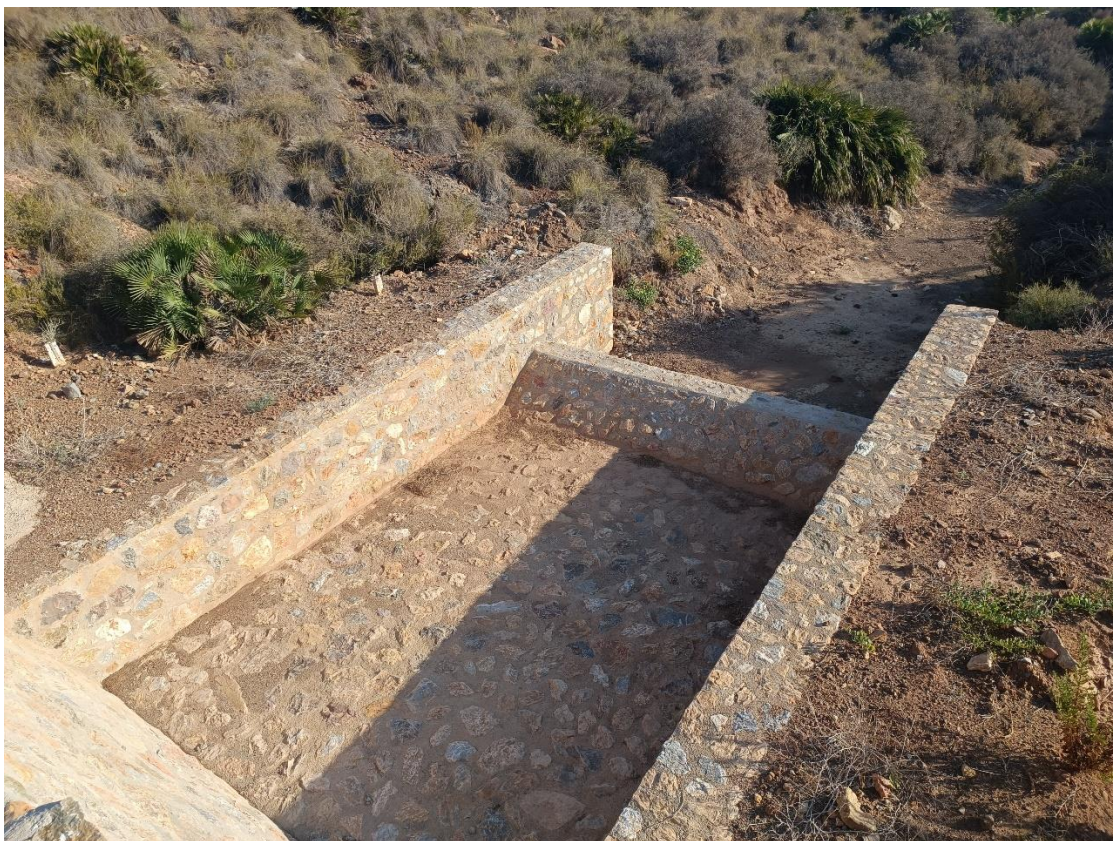
Figura 3 – Dique 1. Cuenco aguas abajo.
