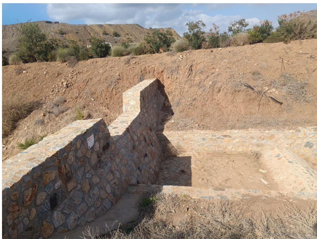
Figura 26 – Dique 8. Vista general.
