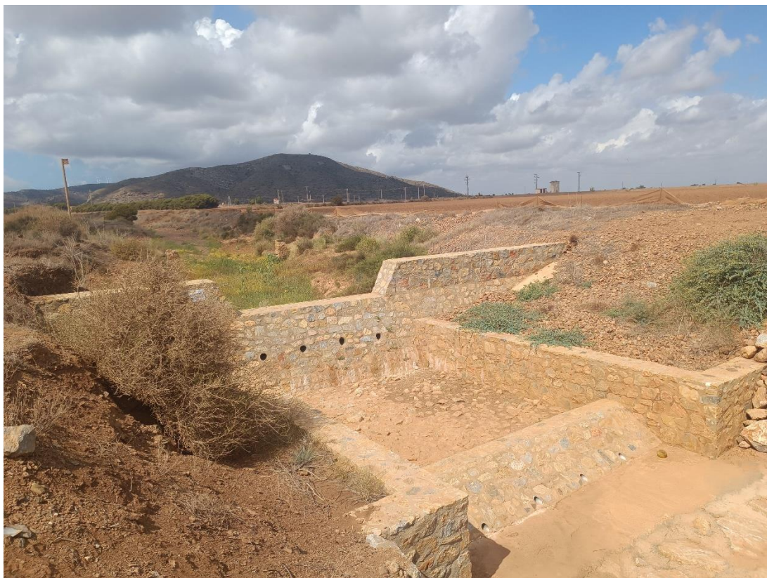
Figura 41 – Dique 10. Vista general.
