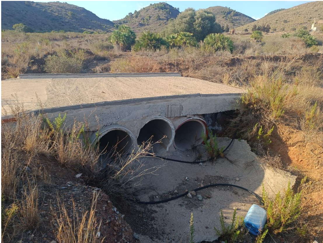
Figura 7 – ODT 2. Vista desde aguas abajo.
